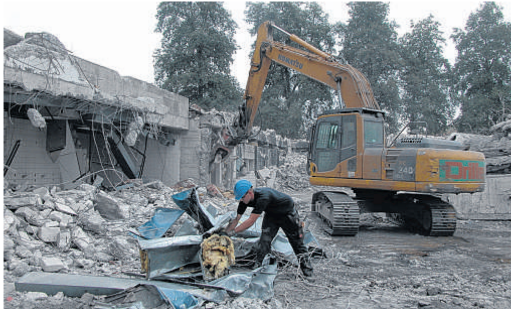
Der Abriss des alten Hüstener Hallenbads nimmt einige Wochen in Anspruch. Die mächtige Betonkonstruktion verlangt den Einsatz schweren Geräts. Metall wird aussortiert. Fotos: Martin Schwarz
